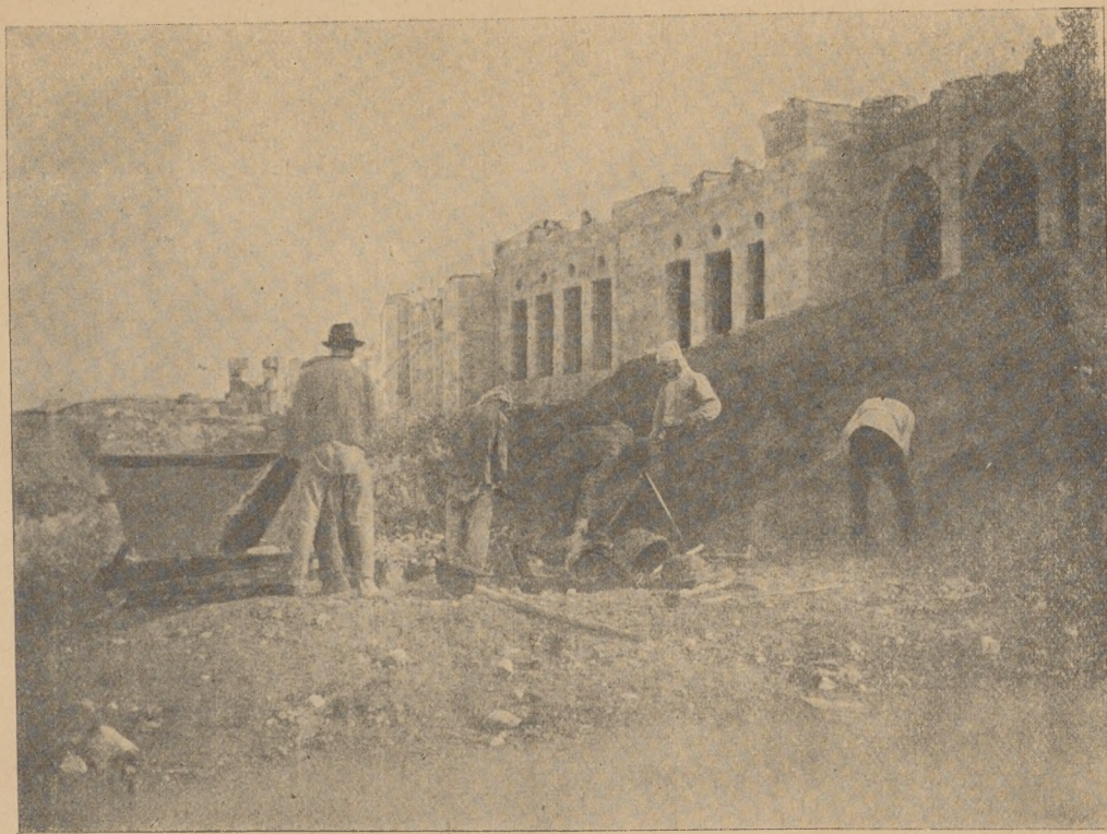
Robotnicy przy budowie gmachu politechniki w Haifie,
